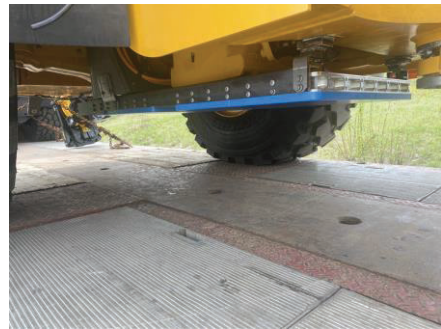
Figur 45, Installation av laddplattor för induktionsladdning
