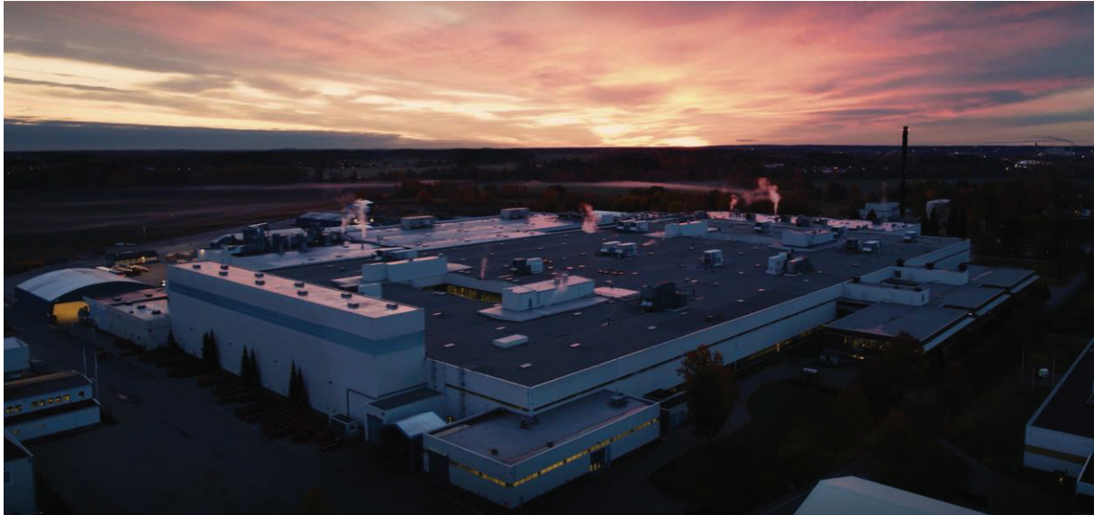
Figur 3, Volvo CE komponentfabrik, Eskilstuna
